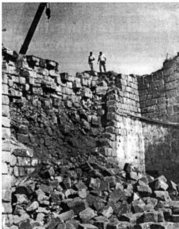
Fig. 10. Derrumbe de un paramento en 1982. (Foto Diario Hoy).
