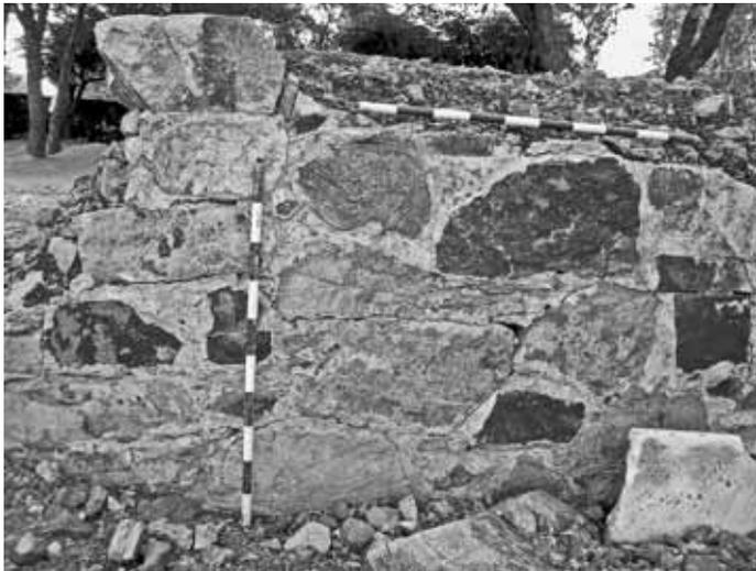
Fig. 12 a) reparación del paramento exterior de la muralla posiblemente en el 866, conservando en el interior la mampostería romana b).
