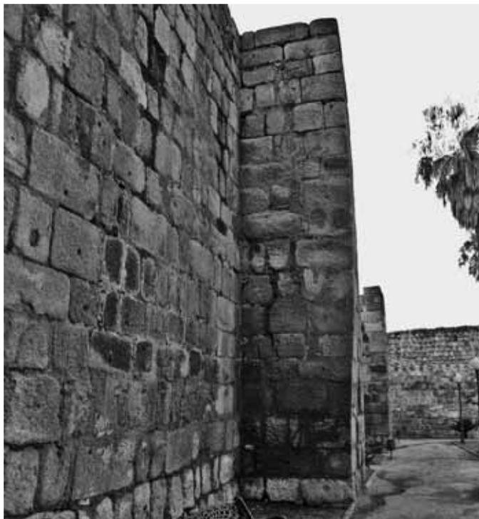
Fig. 9. Abombamiento en los paramentos de la alcazaba del 835.
