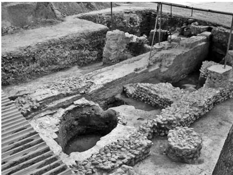
Fig. 11. Cimentaciones corridas de bolos de río como asiento de los muros de tapial (edificio emiral ubicado en una esquina del foro provincial).
