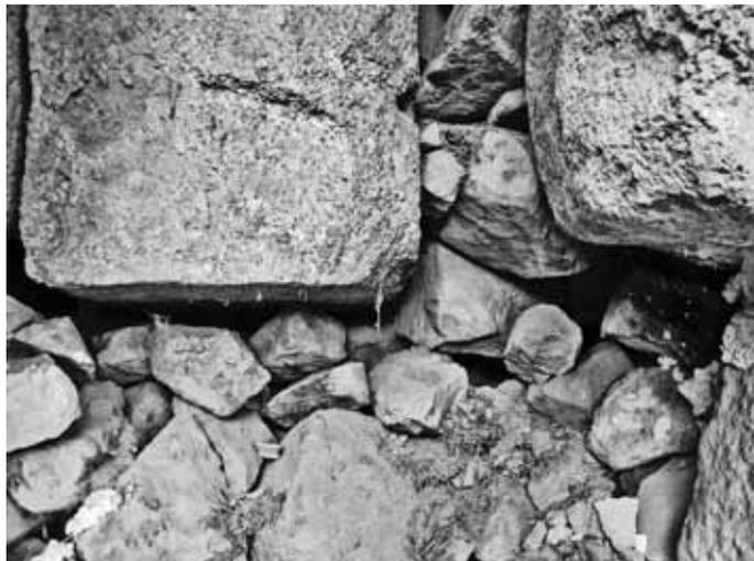
Fig. 8. Interior de los muros originales de la alcazaba, con los materiales sueltos.
