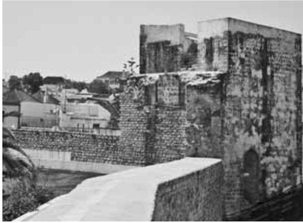
Fig. 16a. Tavira – torre que se apresenta actualmente revestida com aparelho de pedra (alvenaria) mas que deixa ver o taipa no seu interior.
